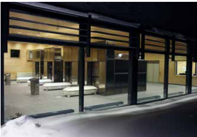
Forbipasserende på gravlunden har frit indkig til arbejdet i ovnrummet. Åbenheden er ualmindelig i forhold til mere traditionelle krematorier, men de første års drift har vist at løsningen opleves som positiv, både for krematoriets ansatte og for publikum. Foto: Roy Carlsen.
